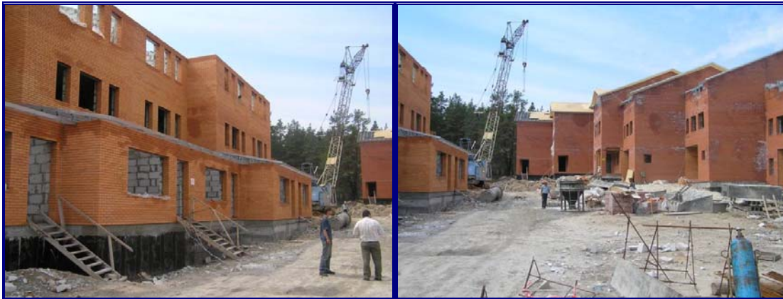
Рисунок 2.2. Будівництво I черги блокованих приватних будинків у с. Плюти, Обухівського району, Київської області станом на кінець червня 2006 року.
