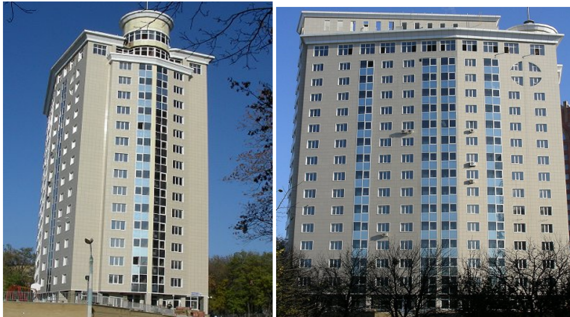
Об'єкт будівництва по пр. Панфілова
