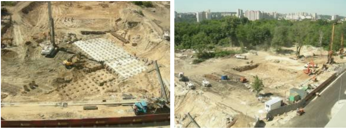
Хід будівництва другої черги (ж/б №6, ж/б№ 7, ж/б№ 9) житлового кварталу з об'єктами соціально-громадського призначення по вул. Професора Підвисоцького у Печерському районі м. Києва на початок червня 2010 р.
