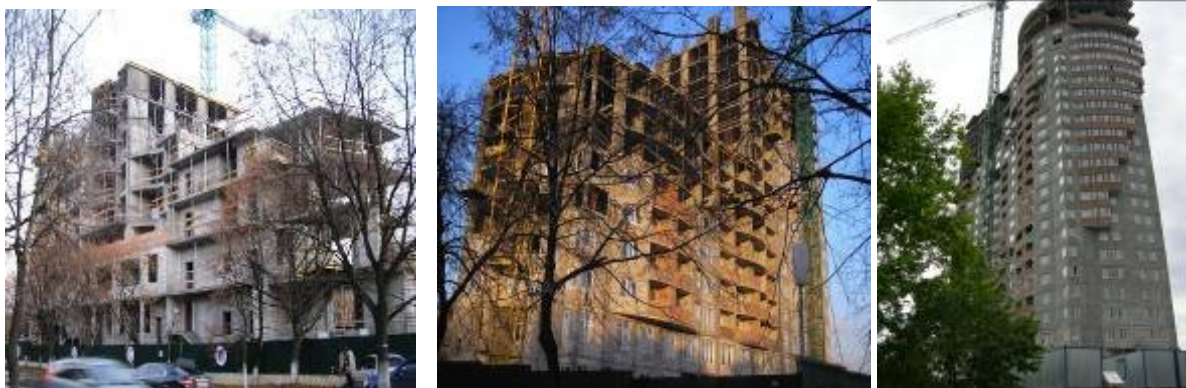
Хід робіт на об'єкті будівництва по вул. П. Запорозця, 26-А станом на (зліва - направо) початок листопада 2007 року, початок лютого 2008 року, початок травня 2008 року
