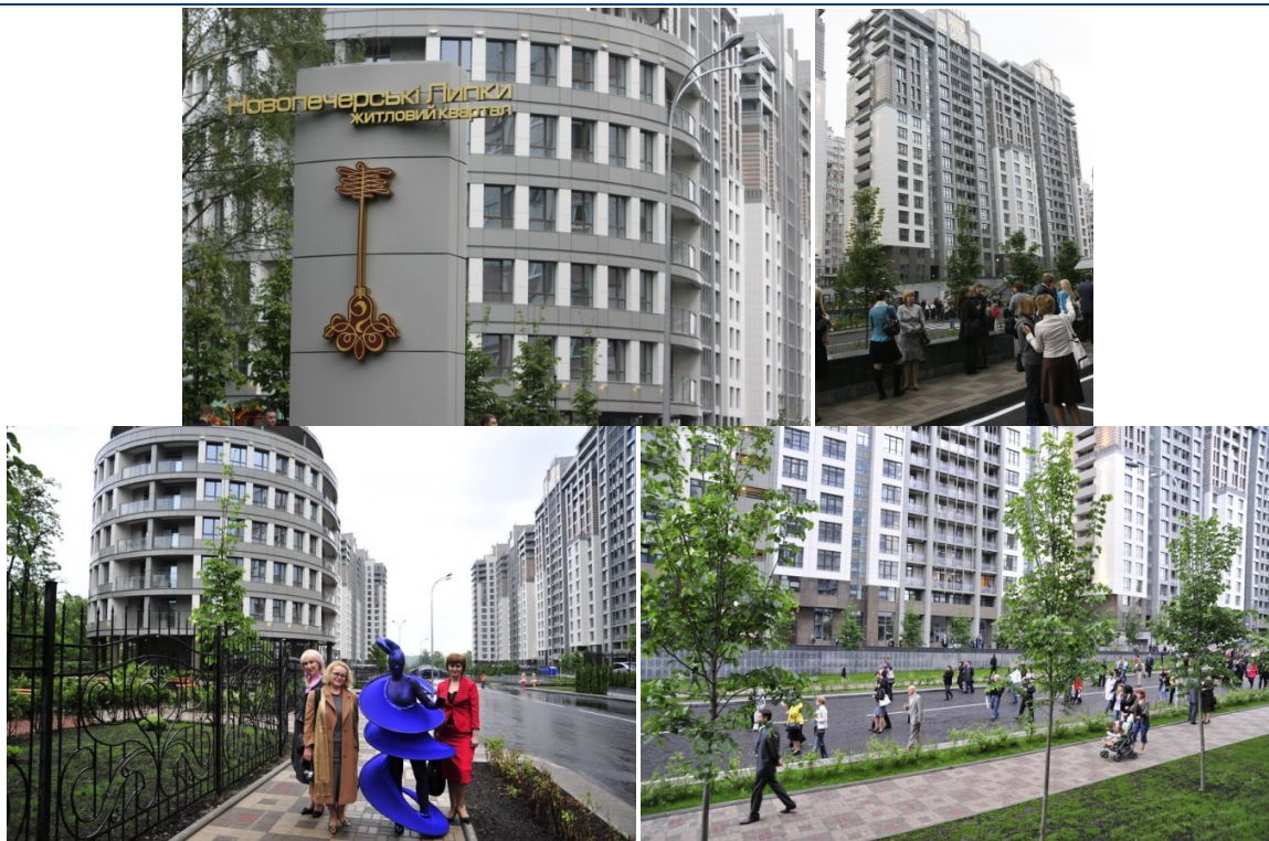
Житловий квартал по вул. Професора Підвисоцького у Печерському районі м. Києва (I черги будівництва)
