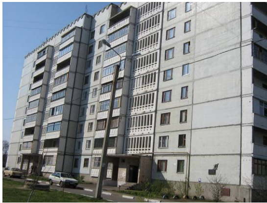
Рисунок.1. Реконструйований гуртожиток по вул. 17 Партз'їзду, 24 та житловий будинок по вул. Зубарева, 32 у м. Харкові (зліва-направо)
