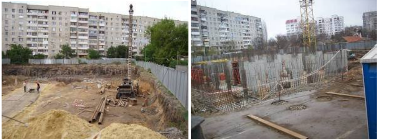
Хід робіт на об'єкті будівництва по вул. Малиновського (в межах вул. Заводської та пров. Союзного) в м. Одесі станом (зліва - направо) на 16.07.2008 р. та на середину лютого 2009 р.
