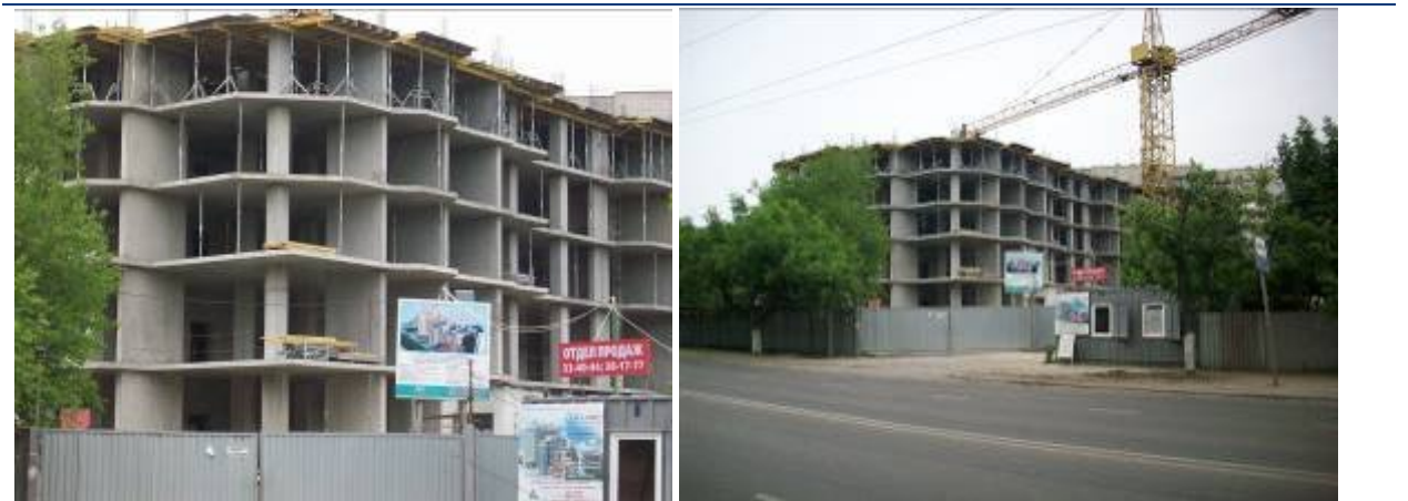
Хід робіт на об'єкті будівництва по вул. Малиновського (в межах вул. Заводської та пров. Союзного) в м. Одесі станом на кінець травня 2009 р.
