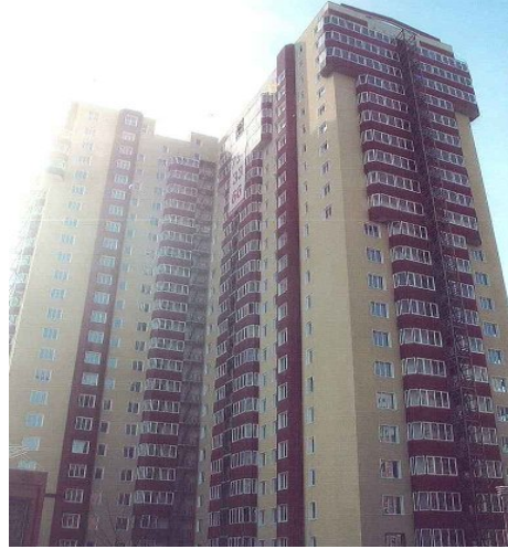
Хід робіт на об'єкті будівництва по вул. 23 Серпня (в районі буд. 31) у м. Харкові станом на кінець квітня 2010 р.
