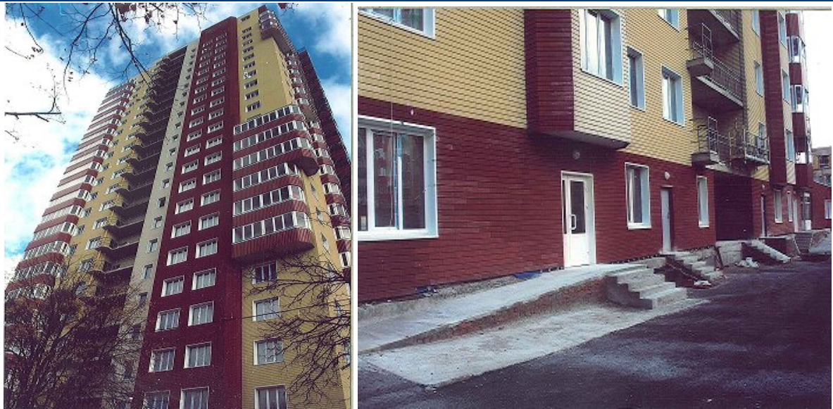
Хід робіт на об'єкті будівництва по вул. 23 Серпня (в районі буд. 31) у м. Харкові станом на кінець жовтня 2010 року
