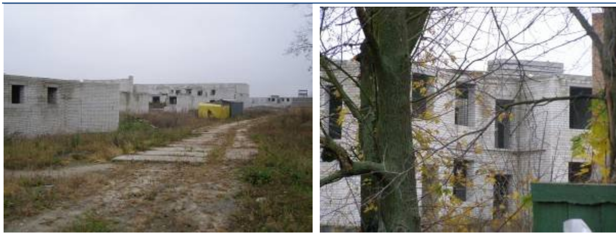
Рисунок Ошибка! Текст указанного стиля в документе отсутствует.. Об'єкт незавершеного будівництва - житловий комплекс з об'єктами соціально-побутової інфраструктури по вул. Леніна, 119 у с. Петропавлівська Борщагівка Києво-Святошинського району Київської області станом на кінець 2010 року (будівельні роботи протягом 9 місяців поточного року не проводилися).
