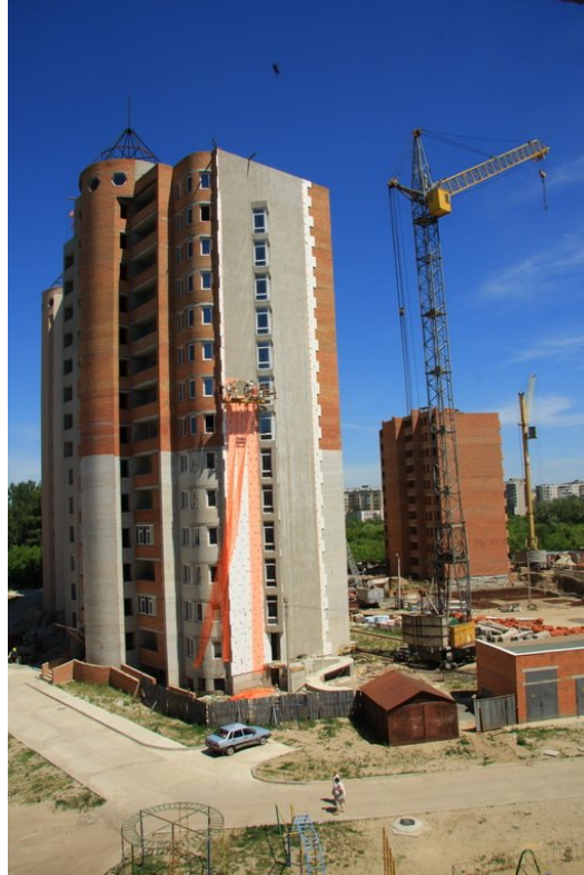
Рисунок 1. Будівництво житлових будинків в м. Сумах по вул. Харківській, 3/1 і 3/2 станом на червень 2010 року
