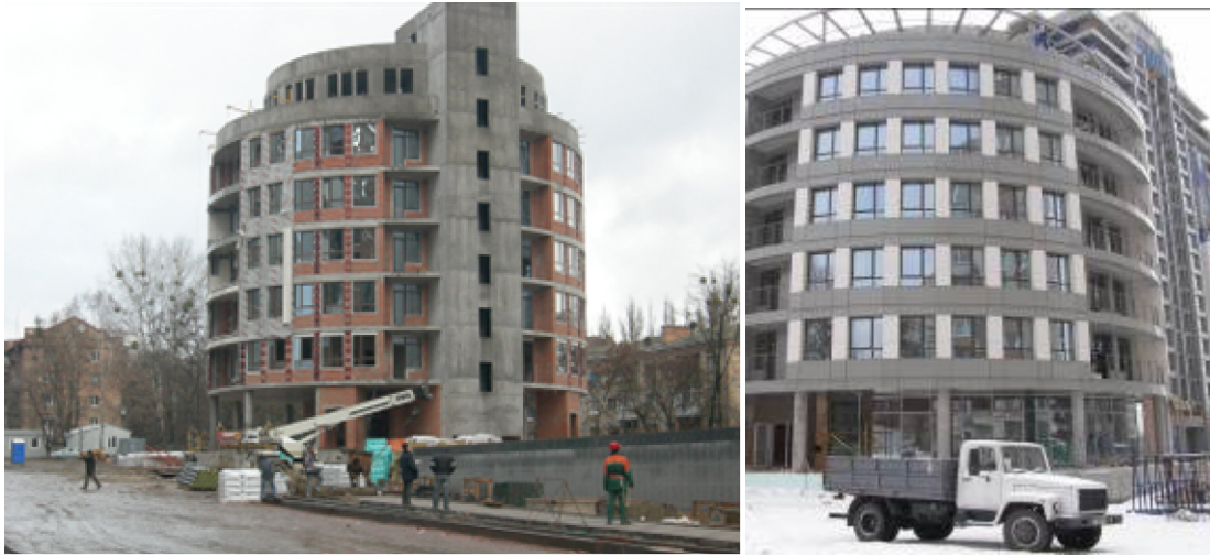
Хід робіт з будівництва ж/б 1 по вул. Професора Підвисоцького у Печерському районі м. Києва станом (зліва-направо): на 19.11.2009 р. та на 18.03.2010 р.
