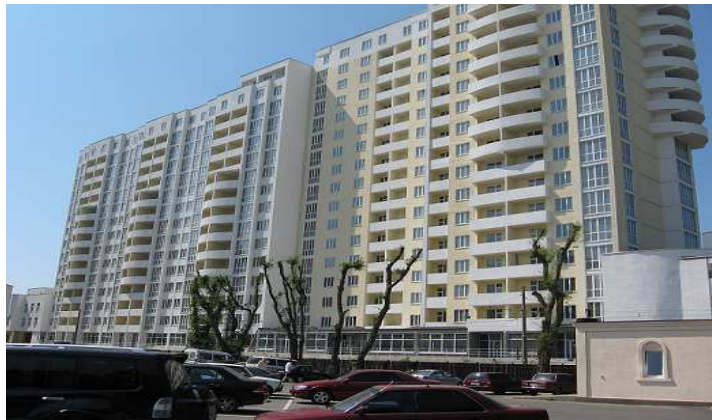
Житловий будинок по вул. Ак. Корольова, 5/2 у м. Одесі
