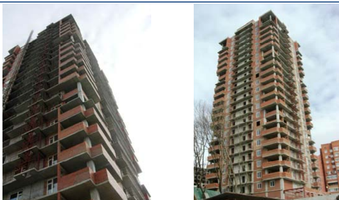
Рисунок 2.7. Хід робіт на об'єкті будівництва по пр. Панфілова у м. Донецьку станом на 21.02.2008 р.(будинок № 1)
