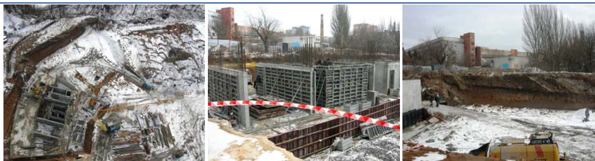
Рисунок 2.8. Хід робіт на об'єкті будівництва по пр. Панфілова у м. Донецьку станом на 21.02.2008 р.(будинок № 2, II-III черги, зліва направо)
