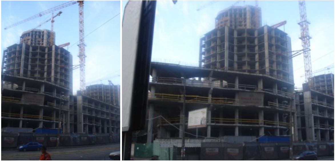
Будівельні роботи на об'єкті будівництва офісно-житлового комплексу в м. Києві на ділянці, обмеженої вулицями Глибочицькою, Студентською та Пимоненка станом на 21.11.2009 р
