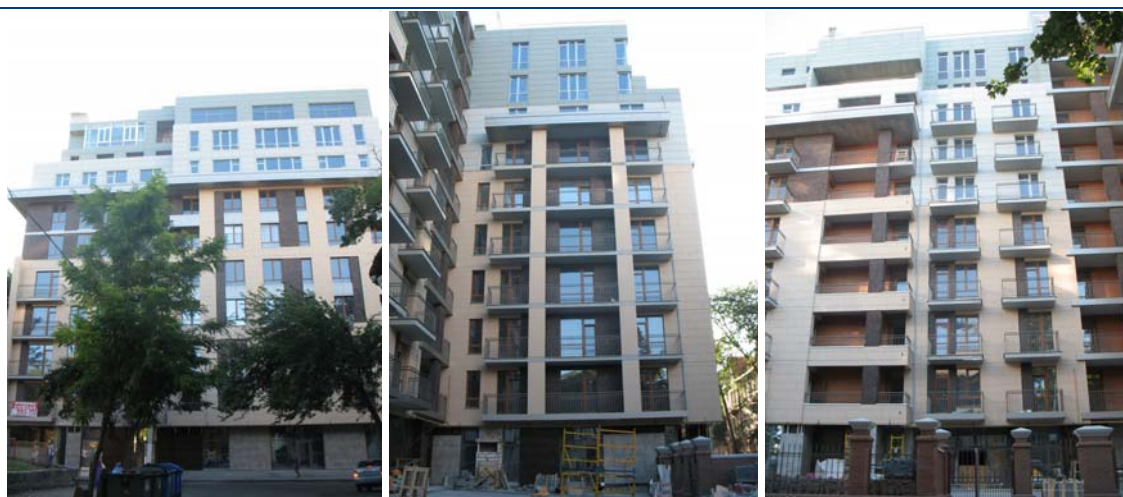
Будівництво житлового будинку по вул. Відрадній, 13 станом на кінець серпня 2011 року
