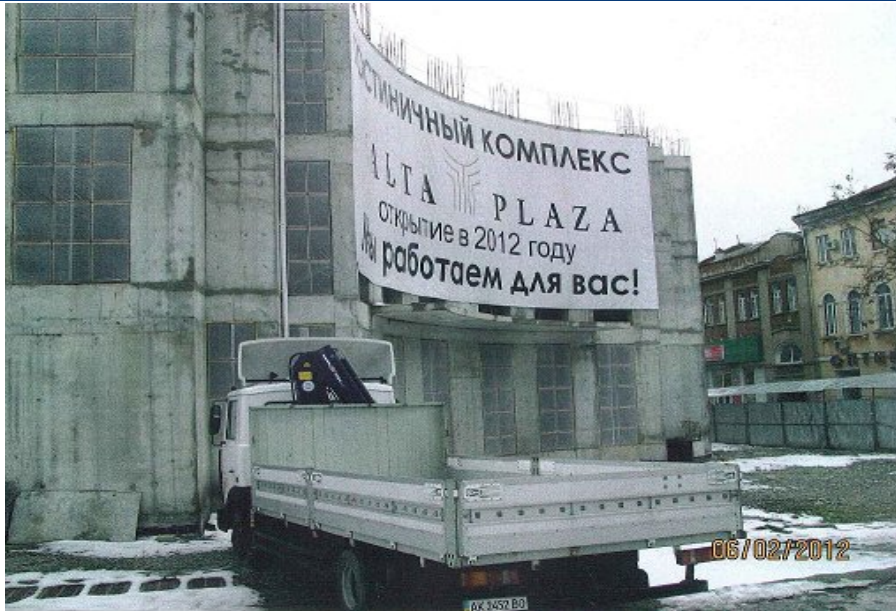
Хід робіт на об'єкті будівництва по вул. Ігнатенко, 9 у м. Ялті станом на 06.02.2012 р.
