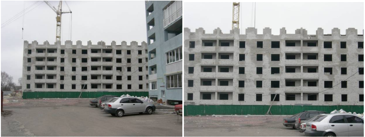
Будівництво ж/б по вул. Новій, 31а станом на 16.02.2009 р.
