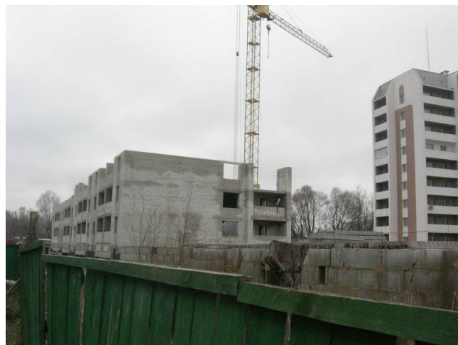
Будівництво ж/б по вул. Головатого, 716 станом на 16.02.2009 р.
