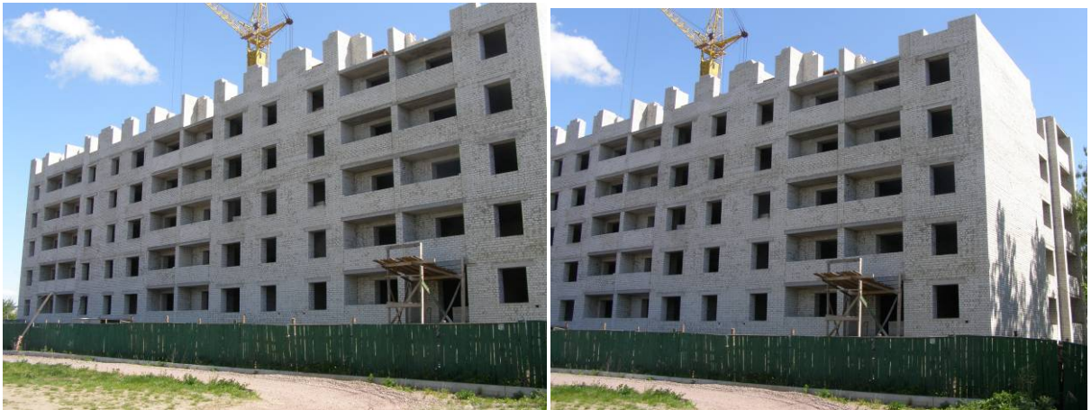
Будівництво ж/б по вул. Новій, 31а станом на 14.05.2009 р.
