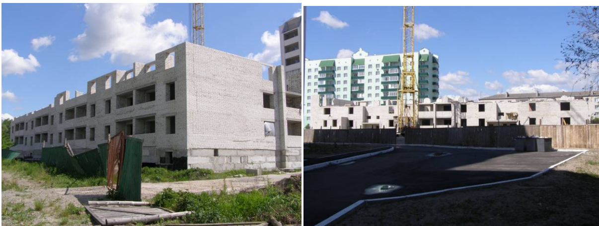
Будівництво ж/б по вул. Головатого, 716 станом на 14.05.2009 р.
