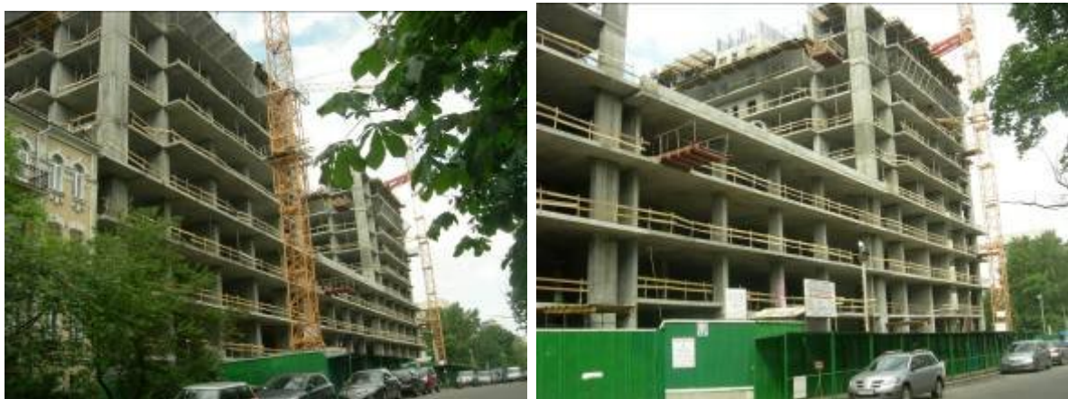
Рисунок 3. Будівельні роботи на об'єкті будівництва, обмеженого вулицями Предславинською, Ульянович та Червоноармійською станом на середину вересень 2010 р.
