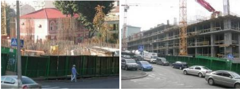
Рисунок 1. Будівельні роботи на об'єкті будівництва, обмеженого вулицями Предславинською, Ульянович та Червоноармійською станом на 21.08.2008 р. та 31.03.2009 р
