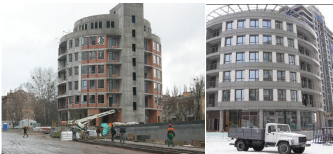
Хід робіт з будівництва ж/б 1 по вул. Професора Підвисоцького у Печерському районі м. Києва станом (зліва-направо): на 19.11.2009 р. та на 18.03.2010 р.
