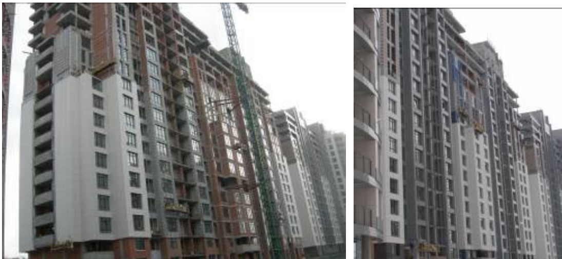
Хід робіт з будівництва ж/б 2 по вул. Професора Підвисоцького у Печерському районі м. Києва станом (зліва-направо): на 19.11.2009 р. та на 18.03.2010 р..
