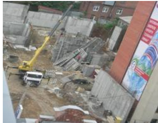
Рисунок 1.10. Будівництво багатофункціонального комплексу по вул. Шевченка, 53, станом на 21.09.2007 р.
