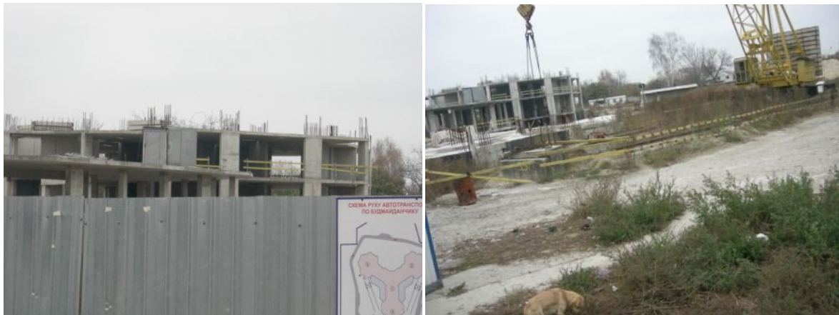
Рисунок 2. Хід робіт на об'єкті будівництва житлового комплексу по вул. Київський шлях, 28 у м. Борисполі станом на 05.11.2009 р.
