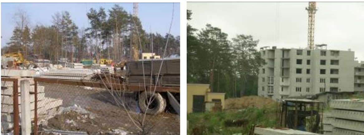
Будівництво житлового комплексу (II черга) в Київській області с. Чайки по вул. Лобановського, 1 станом на кінець березня 2010 р. та на кінець травня 2010 р.
