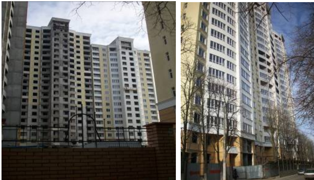
Будівництво житлового комплексу вул. Армійській, 11 станом на 04.03.2010 р.
