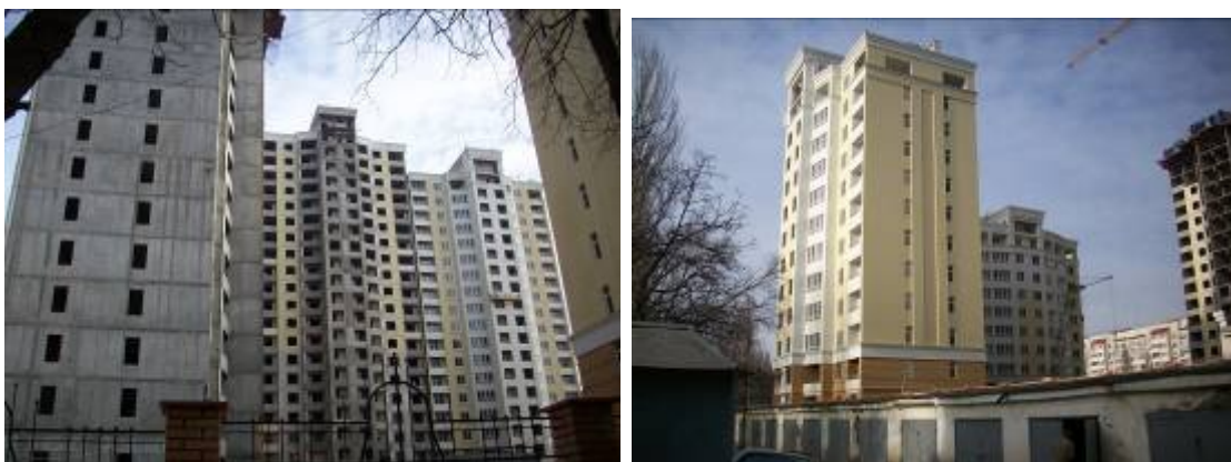
Будівництво житлового комплексу вул. Армійській, 11 станом на кінець травня 2010 р.
