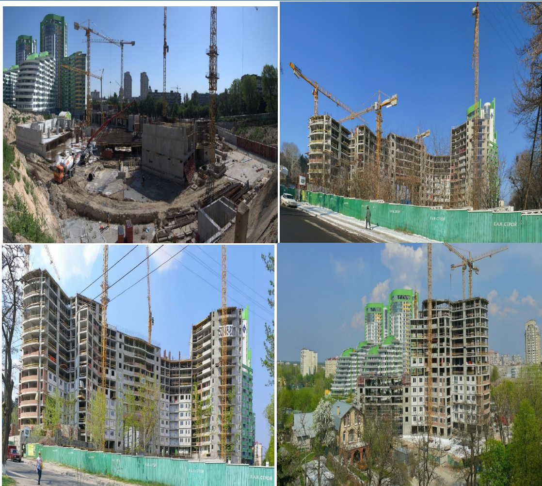
Рисунок 1.1 Стан будівництва II черги житлового комплексу по вул. Вишгородській, 45 у м. Києві у липні, лютому 2010 року та квітні 2011 року (зверху вниз)
