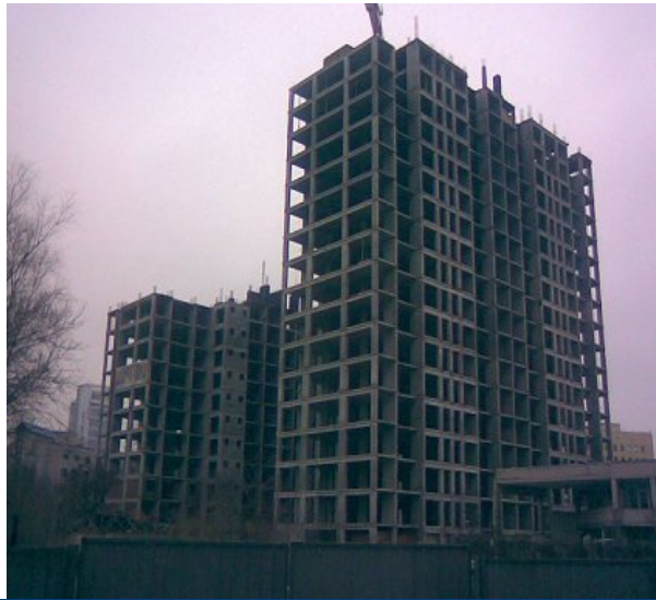
Хід робіт на об'єкті будівництва по пров. Ламаному в м. Дніпропетровську станом на 01.03.2010 р.
