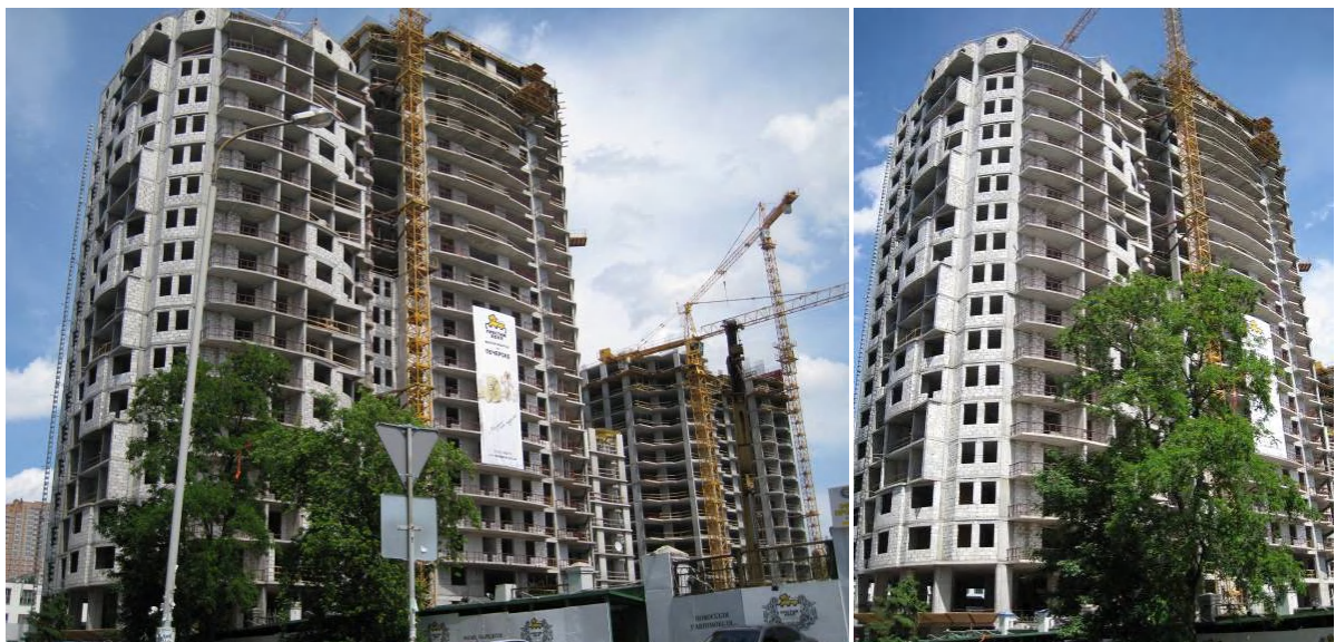
Будівництво житлово-офісного комплексу з вбудованими, прибудованими приміщеннями та підземним паркінгом по вул. Анрі Барбюса, 37/1 у Печерському районі м. Києва станом на 08.06.2009 р.
