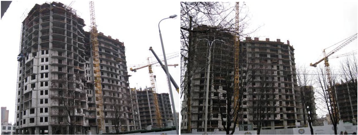
Будівництво житлово-офісного комплексу з вбудованими, прибудованими приміщеннями та підземним паркінгом по вул. Анрі Барбюса, 37/1 у Печерському районі м. Києва станом на 24.03.2009 р.
