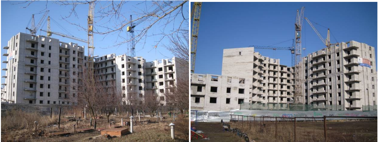
Хід робіт на об'єкті будівництва по пр. Тракторобудівників, в районі буд. 103 А у м. Харкові станом на 20.02.2009 р.
