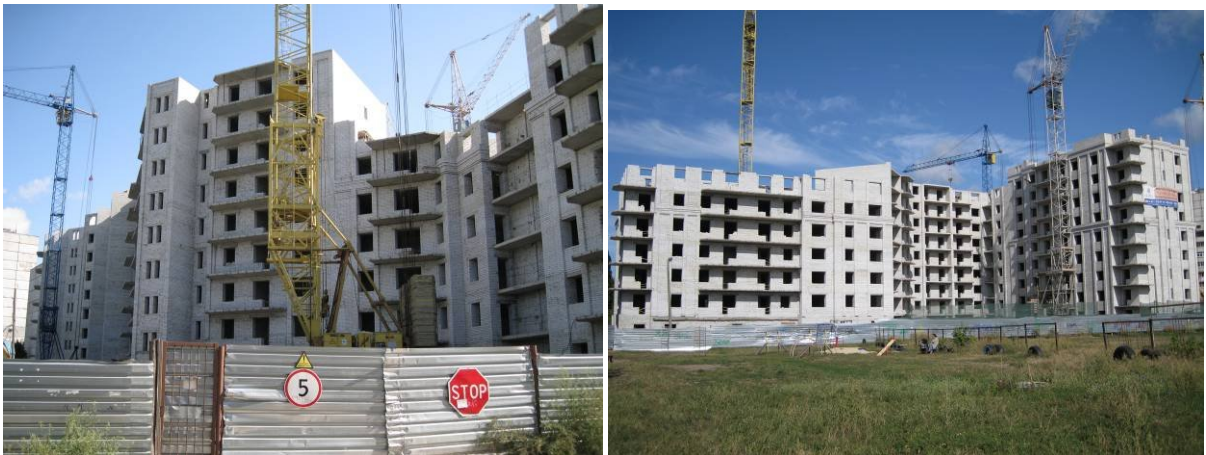
Хід робіт на об'єкті будівництва по пр. Тракторобудівників, в районі буд. 103 А у м. Харкові станом на 21.08.2009 р.
