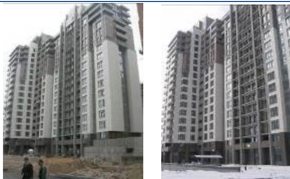
Ж/б 5 по вул. Професора Підви́соцького у Печерському районі м. Києва
