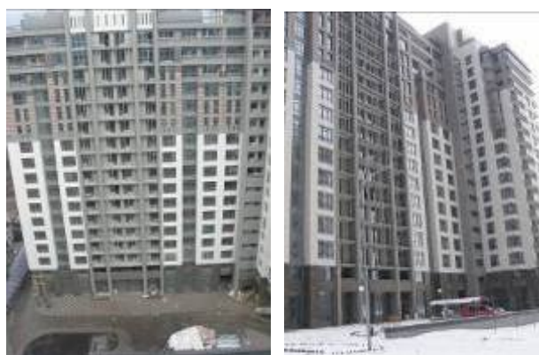
Ж/б 3 по вул. Професора Підвисоцького у Печерському районі м. Києва
