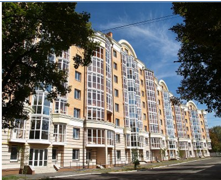
Житловий будинок по вул. Жовтневій, 40-В у м. Полтаві, станом на 14.09.2010 р.
