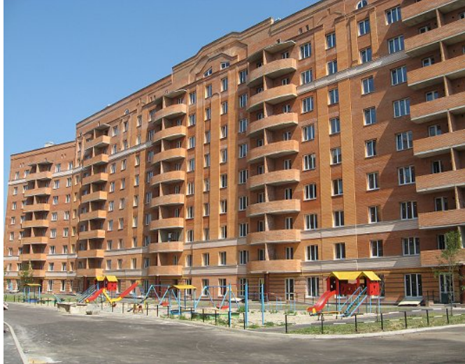
Житловий будинок по вул. Жовтневій, 40-Д у м. Полтаві, станом на 19.07.2010 р.
