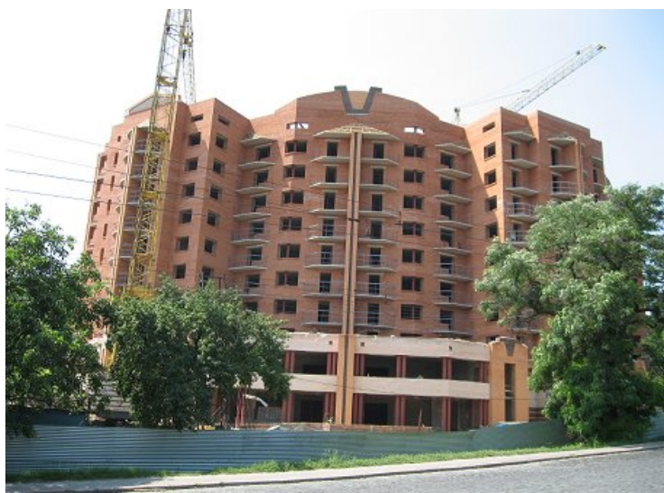
Житловий будинок по вул. Леніна, 74 у м. Полтаві, станом на 19.07.2010 р.
