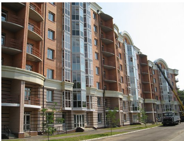
Житловий будинок по вул. Жовтневій, 40-В у м. Полтаві, станом на 19.07.2010 р.
