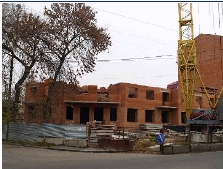
Житловий будинок по вул. Паризької комуни, 24 (II черга) у м. Полтаві, станом на 26.10.2010 р.
