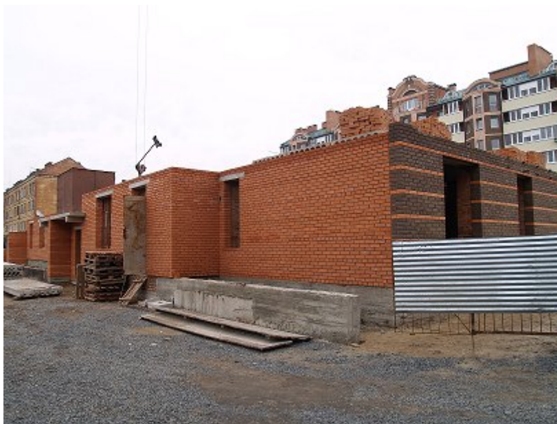
Житловий будинок по вул. Пролетарська, 27-29 у м. Полтаві, станом на 26.10.2010 р.
