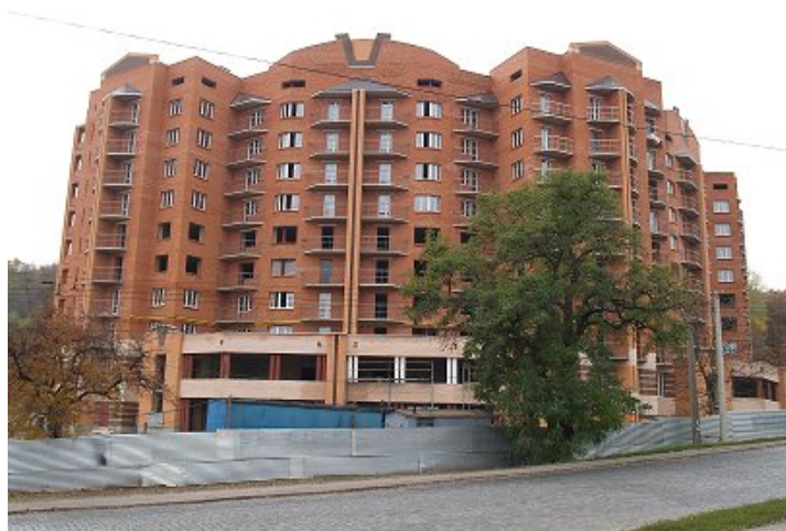
Житловий будинок по вул. Леніна, 74 у м. Полтаві, станом на 2010 р.
