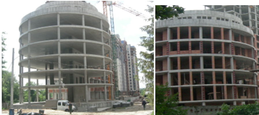
Хід робіт з будівництва ж/б 1 по вул. Професора Підвисоцького у Печерському районі м. Києва станом (зліва-направо): на 18.06.2009 р. та на 03.09.2009 р.
