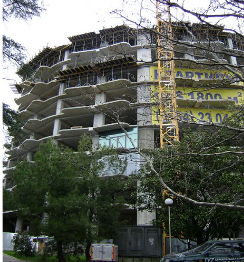
Будівництво багатоповерхового житлового будинку по вул. К. Маркса, 18а у м. Ялті станом на 04.03.2010 р.
