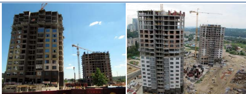
Хід будівництва другої черги житлового кварталу з об'єктами соціально-громадського призначення по вул. Професора Підвисоцького у Печерському районі м. Києва на травень 2011 року та серпень 2011 року (зліва направо)
