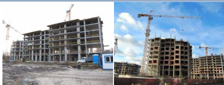
Хід будівництва другої черги житлового кварталу з об'єктами соціально-громадського призначення по вул. Професора Підвисоцького у Печерському районі м. Києва на листопад 2010 року та лютий 2011 року (зліва направо)
