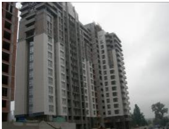
Хід робіт з будівництва ж/б 3 по вул. Професора Підвисоцького у Печерському районі м. Києва станом (зліва-направо): на 18.06.2009 р. та на 03.09.2009 р.
