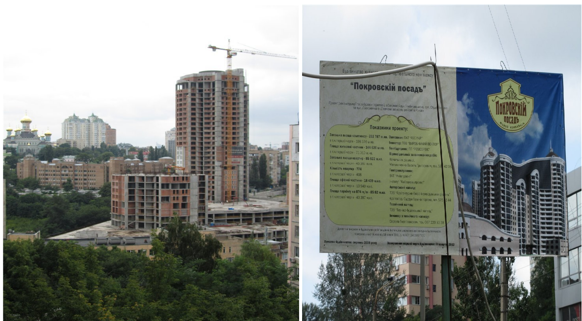
Рисунок 1. Будівельні роботи на об'єкті будівництва офісно-житлового комплексу в м. Києві на ділянці, обмеженої вулицями Глибочицькою, Студентською та Пимоненка станом на початок серпня 2011 року
