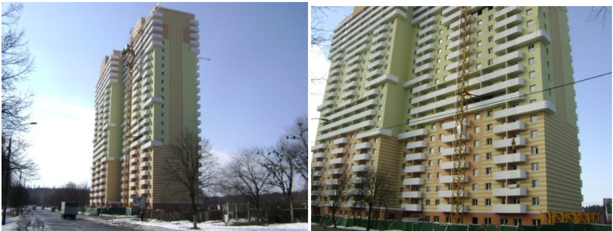
Рисунок 2. Будівельні роботи на об'єкті будівництва в м. Києві по вул. Генерала Наумова, 66 станом на березень 2010 р.
