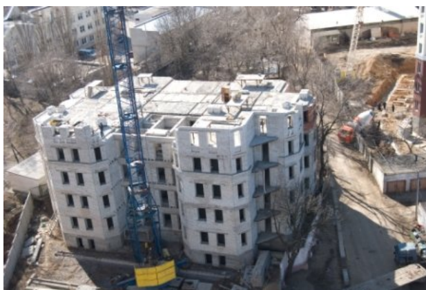
Рисунок 2. Стан будівництва по вул. Хантадзе, 7 Б у м. Іллічівську станом на березень 2010 року
