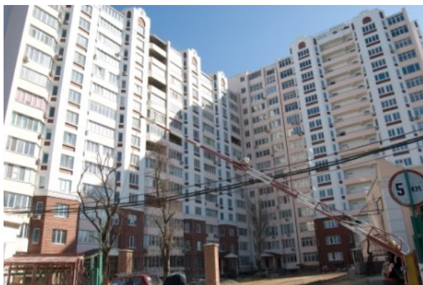
Рисунок 1. Стан будівництва по пров. Хантадзе, 4 (раніше вул. Хантадзе, 9), I та II черги у м. Іллічівську станом на березень 2010 року
