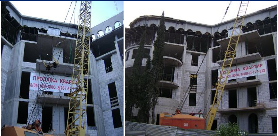
Рисунок Ошибка! Текст указанного стиля в документе отсутствует..2. Стан будівництва житлового будинку по вул. Батуріна, 44А у смт. Лівадія м. Ялти станом на 04.06.2009 р.
