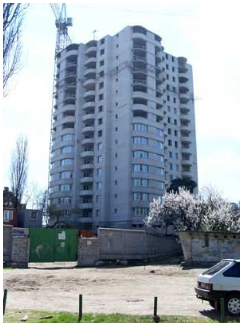
Будівництво житлового будинку по бул. Я. Гашека, 8а станом на початок травня 2009 р.
