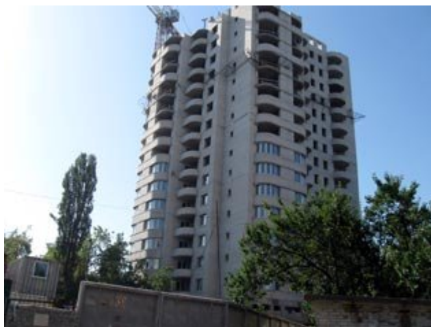
Будівництво житлового будинку по бул. Я. Гашека, 8а станом на 09.09.2009 р.
