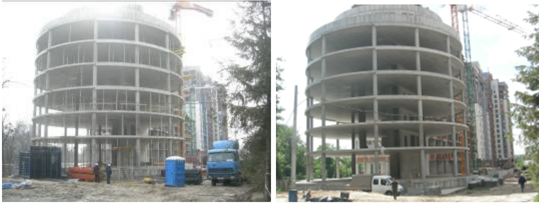
Хід робіт з будівництва ж/б 1 по вул. Професора Підвисоцького у Печерському районі м. Києва станом (зліва-направо): на 12.03.2009 р. та на 18.06.2009 р.
