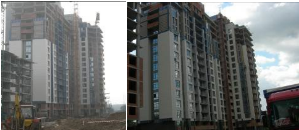
Хід робіт з будівництва ж/б 3 по вул. Професора Підвисоцького у Печерському районі м. Києва станом (зліва-направо): на 12.03.2009 р. та на 18.06.2009 р.
