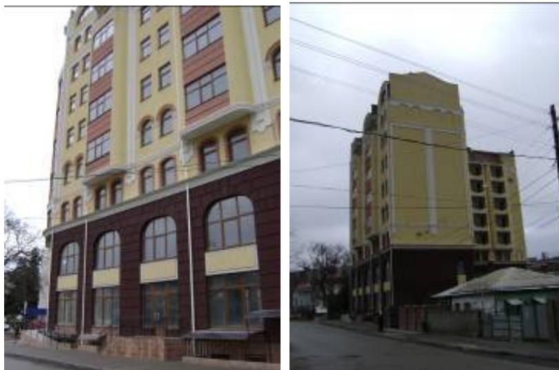
Об'єкт будівництва по вул. Баглікова в м. Алушті станом на початок березня 2010 року
