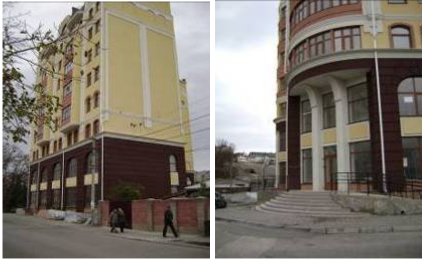
Об'єкт будівництва по вул. Баглікова в м. Алушті станом на середину листопада 2009 року
