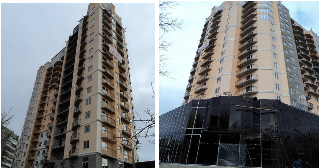
Хід робіт на об'єкті будівництва по вул. Малиновського (на розі вул. Заводської та пров. Союзного) в м. Одесі станом на початок березня 2011 року
