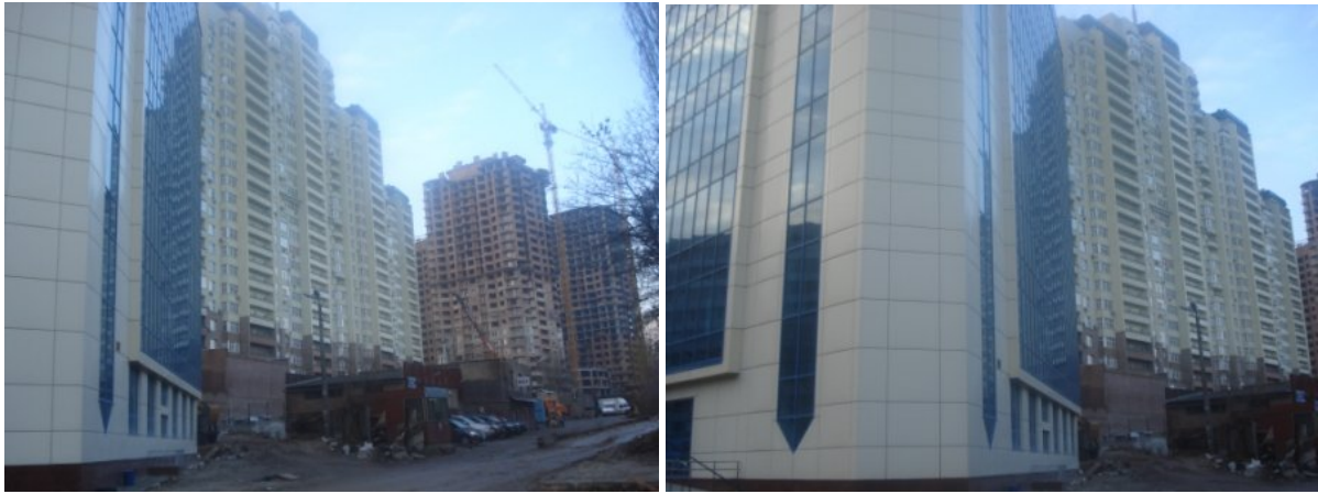
Житловий комплекс по вул. Механізаторів, 2 (ж/к «Времена года») у Солом'янському районі м. Києва
