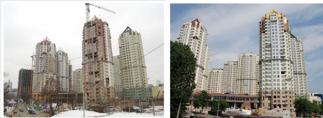
Рисунок 1.1. Будівельні роботи на об'єкті будівництва житлового комплексу по вул. Механізаторів, 2 (ж/к «Времена года») у Солом'янському районі м. Києва станом на 01.03.2009 р. (зліва) та 01.06.2009 р. (справа)
