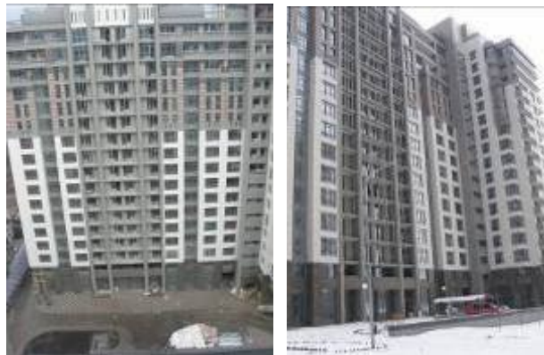
Ж/б 3 по вул. Професора Підвисоцького у Печерському районі м. Києва
