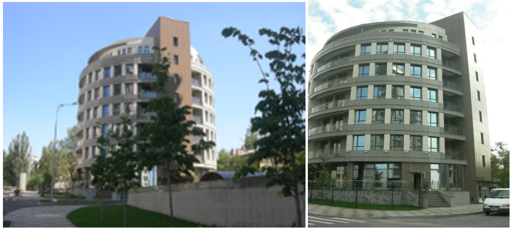
Об'єкт будівництва - ж/б 1 по вул. Професора Підвисоцького у Печерському районі м. Києва станом (зліва-направо): на 08.06.2010 р. та 22.09.2010 р.
