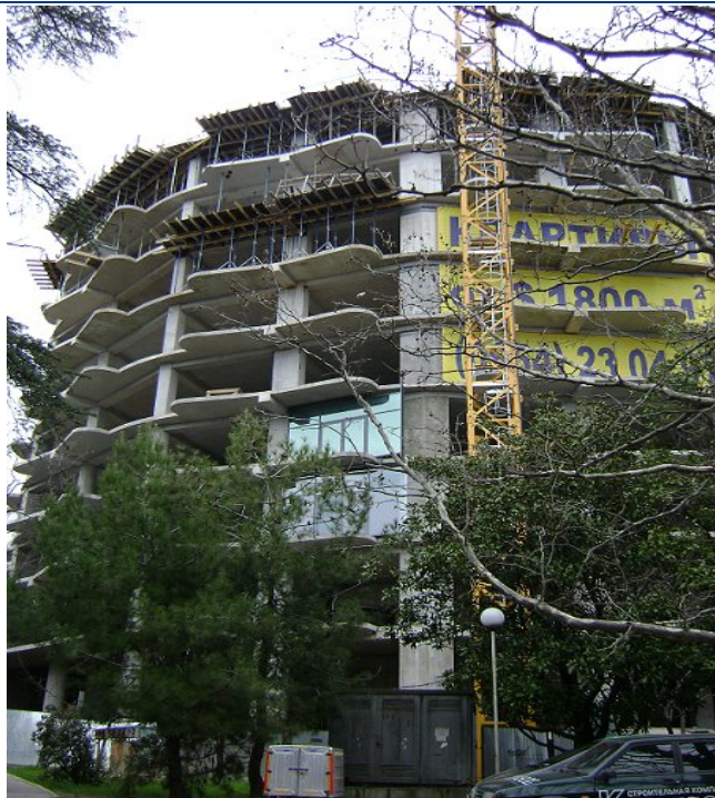
Будівництво багатопверхового житлового будинку по вул. К. Маркса, 18а у м. Ялті станом на 04.03.2010 р.
