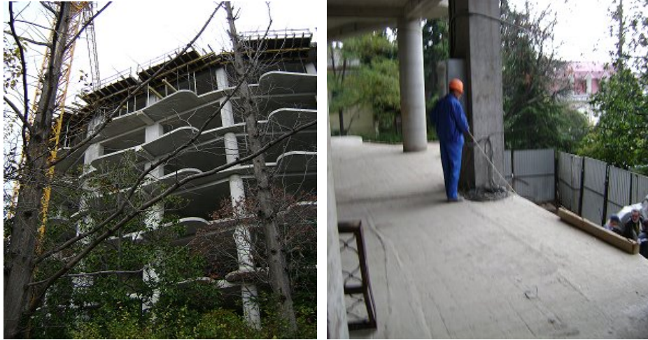
Будівництво багатопверхового житлового будинку по вул. К. Маркса, 18а у м. Ялті станом на 19.11.2009 р
