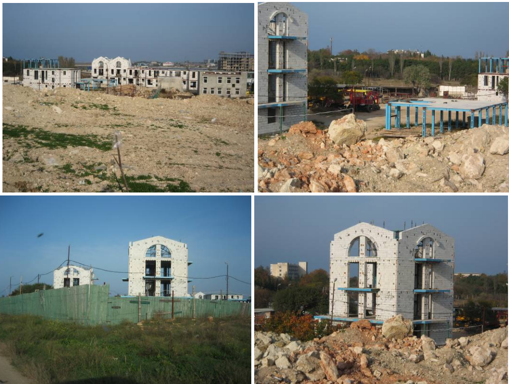
Рисунок 1.2. Будівельні роботи із зведення пансіонату котеджного типу в бухті «Омега» у м. Севастополі на кінець 2008 року
