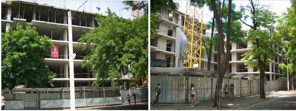
Рисунок 2.2. Будівництво житлового будинку по вул. Відрадній, 13 станом на кінець травня 2009 року
