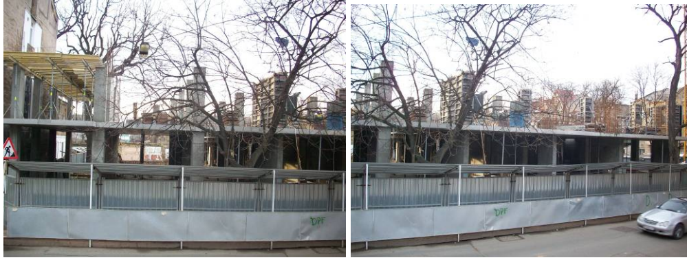
Рисунок 2.1. Будівництво житлового будинку по вул. Відрадній, 13 станом на середину лютого 2009 року
