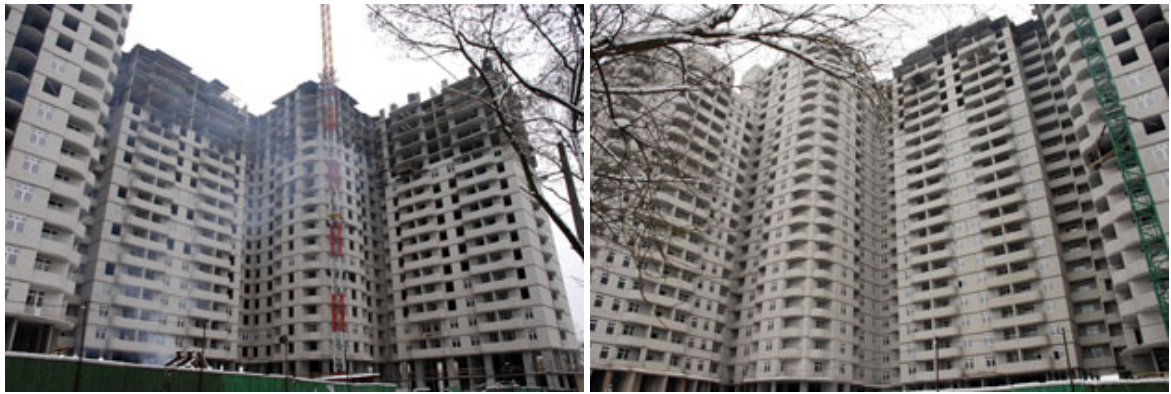
Будівельні роботи по вул. Майорова, 5А станом на середину лютого 2009 року
