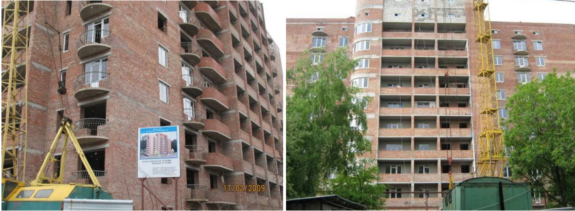
Стан будівництва житлового будинку по вул. Бакинських Комісарів, 100 у м. Донецьку станом на 17.02.2009 р. та станом на 29.05.2009 р.
