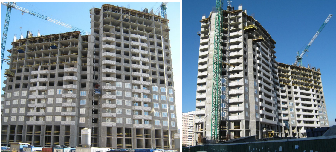
Рисунок 1. Стан будівництва житлового будинку по вул. О. Пчілки у 4-му м/н ж/м Позняки на 20.09.2009 р.
