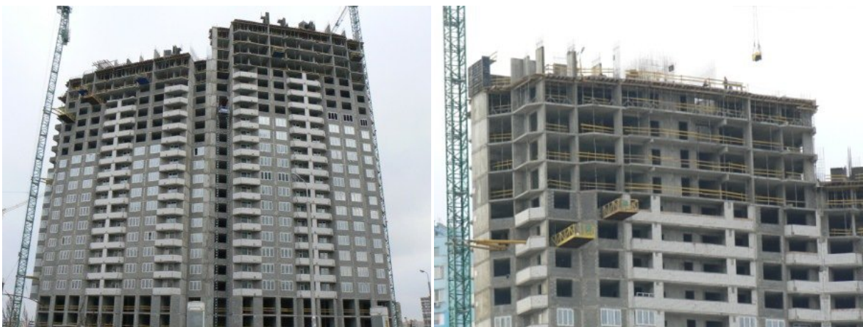
Рисунок 2. Стан будівництва житлового будинку по вул. О. Пчілки у 4-му м/н ж/м Позняки на грудень 2009 р.
